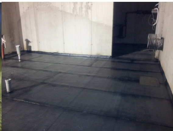
Izvedene horizontalne hidroizolacije in toplotne izolacije v vseh etažah vključno z estrihi in celotni talnim gretjem
