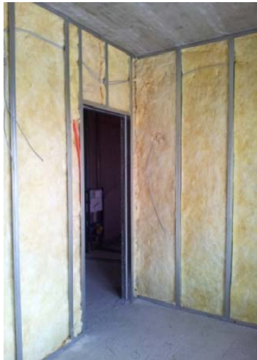
Izvedena montaža suhomontažnih pregradnih sten
