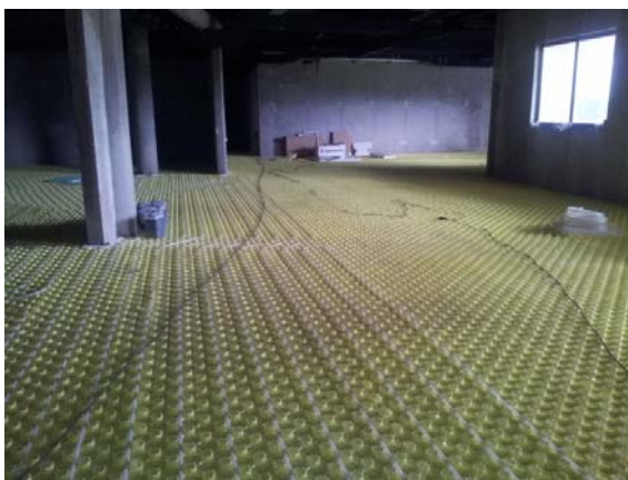
Izvedene horizontalne hidroizolacije in toplotne izolacije v vseh etažah vključno z estrihi in celotni talnim gretjem
