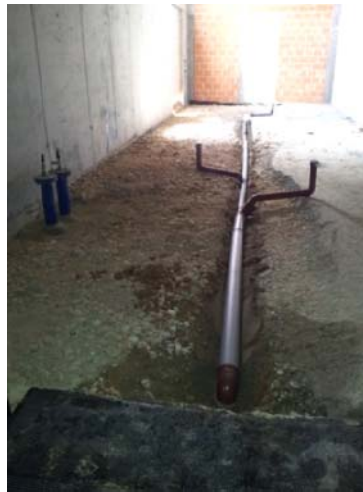
Dokončana vsa kanalizacija pod nivojem podložnega betona
